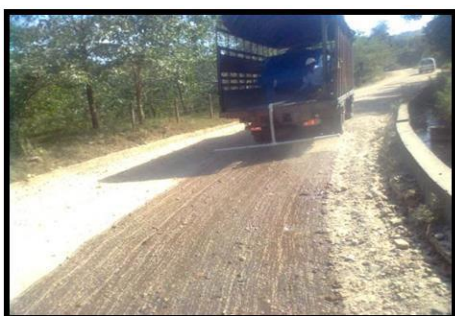
Proceso de aspersión de aceite en vías
